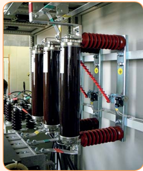
Установка внутренних держателей предохранителей*
